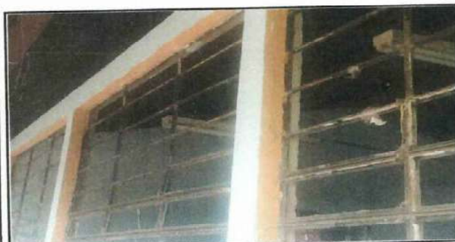
Foto 5: Reparación y refuerzo con barillas de metal soldadas y pintadas de metal de 3 aulas del edificio educativo
