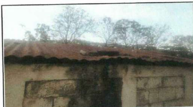
Foto 4: Reparación y cernido de paredes del edificio educativo.
